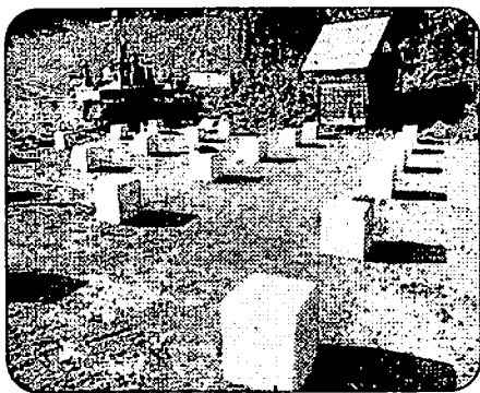
基礎工事が済んだ 佐用郡の太陽光発電用地
